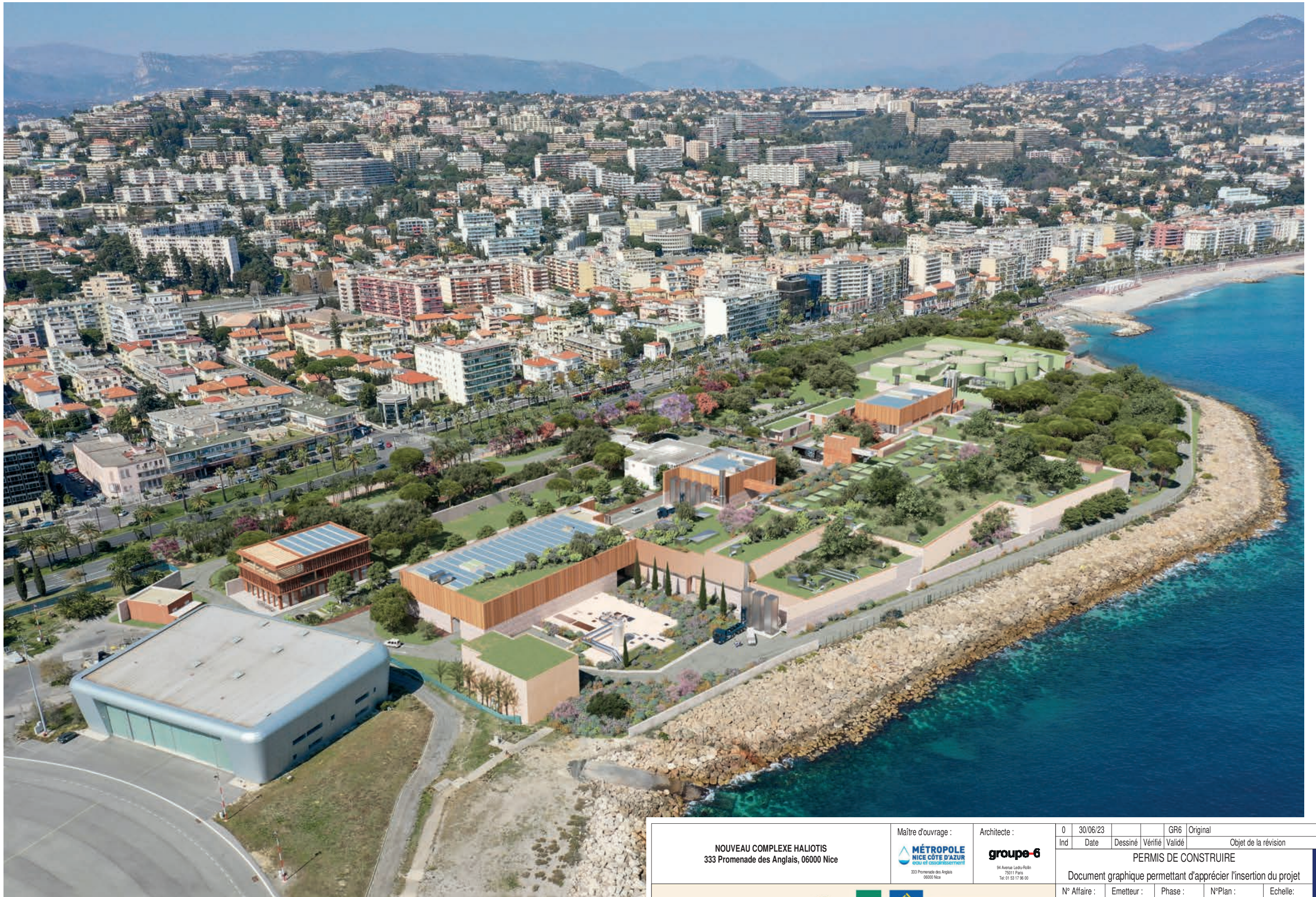
Vue 3 : aérienne Nord-Ouest
